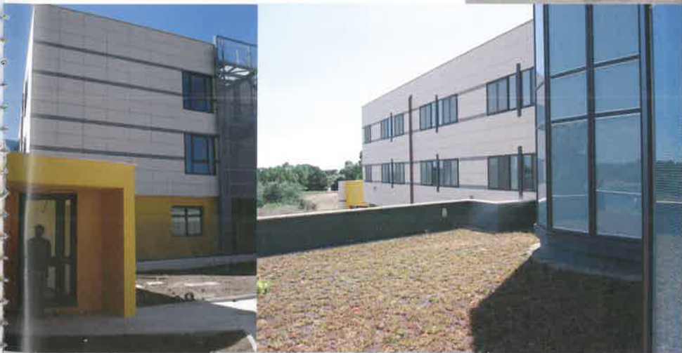
Ingresso laterale. Il tetto giardino della RSA.
