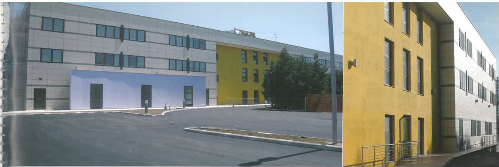
Vista del retro della struttura.
